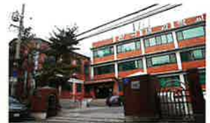
写真2 韓国製菓学校外観
